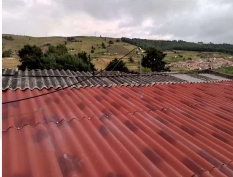
Ilustración 13 Cambio de Cubiertas
